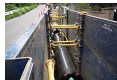
〔水道耐震管の施工状況〕
