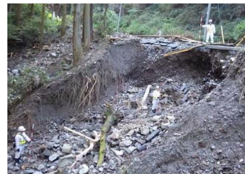
既存盛土の調査状況 ▶ 出典：国土交通省
