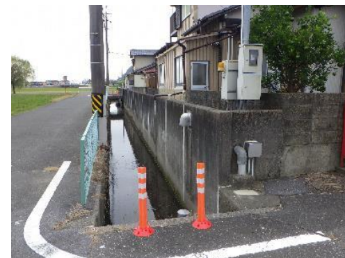
片山雨水ポンプ
