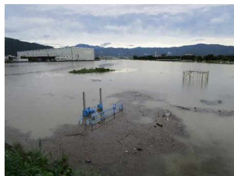
冠水状況（8/31正午頃）
