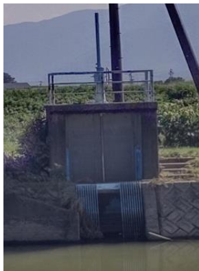
泥川取水ゲート
