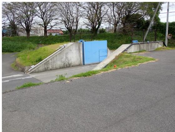
杭瀬川 笠木南陸閘
