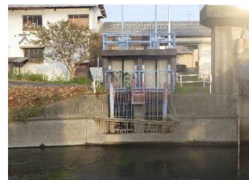
赤坂市橋用水取水ゲート（中川）
