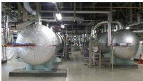
高圧第1、2給水加熱器（解体前）
