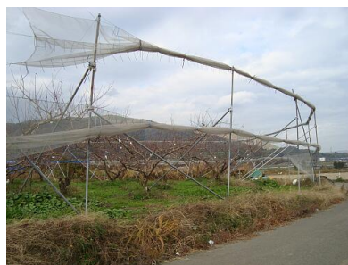
写真1 防風ネットの巻き上げの様子
