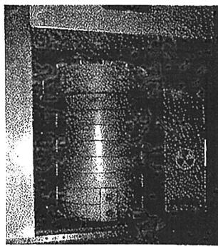
高感度型主蒸気管モニタ
