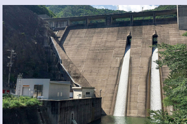
【郡上市】 阿多岐水力発電所
