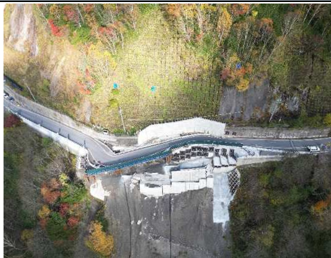
施工中（R6.10月時点）
