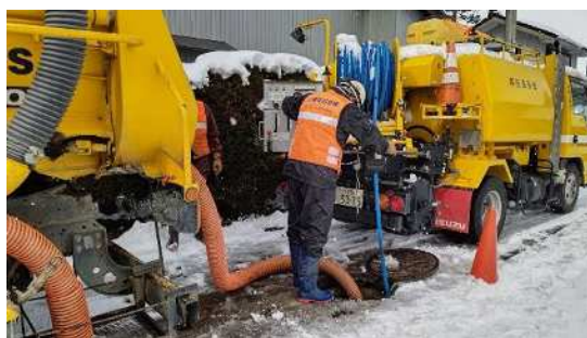
下水道二次調査 (石川県中能登町)
