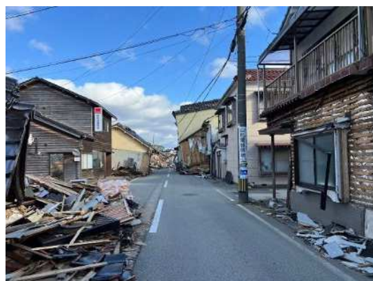
倒壊家屋の影響による道路封鎖 (石川県輪島市)
