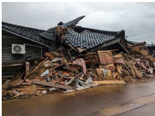
家屋被害の状況 (石川県中能登町)
