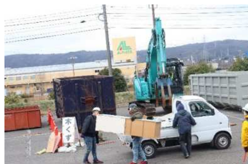
災害廃棄物の処理
