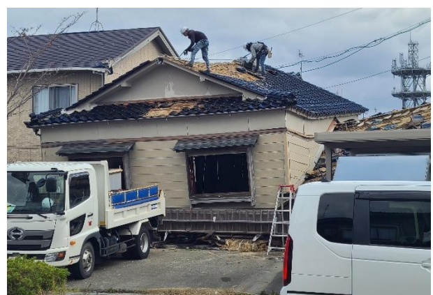
解体中の被災家屋
