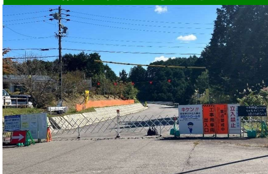
整備中区分(起点側)の状況
