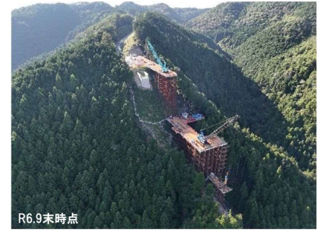
7号橋仮橋工事
