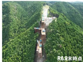
②R5新丸山ダム国道418号7号橋飯地下部工事
