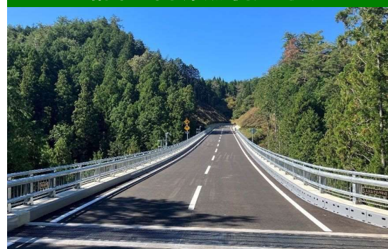
整備中区分(終点側)の状況
