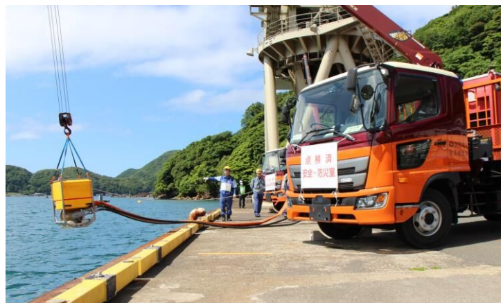
訓練の実施状況（高浜発電所）
