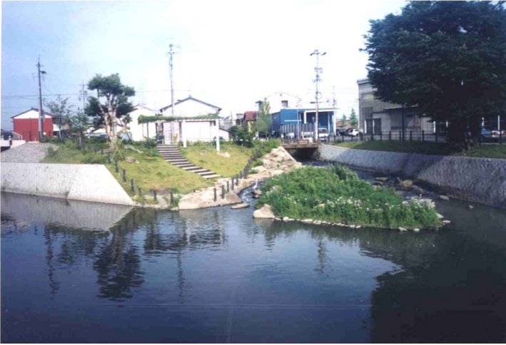
領下川合流部 緩斜面護岸
