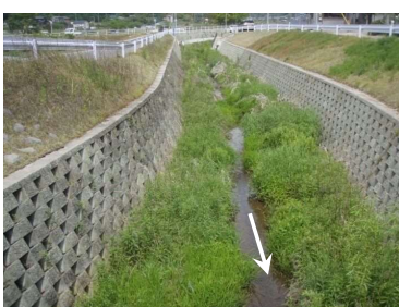
景観の向上(みお筋・緑化護岸)
