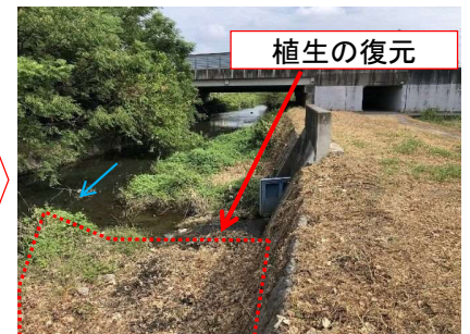
施工後11年経過 (R6)
