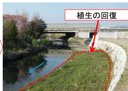
施工後1年経過 (H26)
