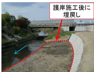
施工直後の状況 (H25)
