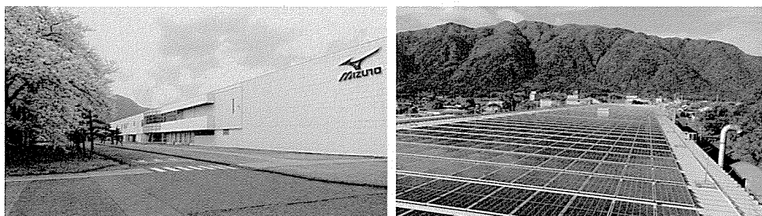
Fig.4 ゴルフ製造棟（左）とゴルフ製造棟に設置した太陽光パネル
