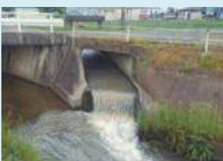
9-③ 用排水路・河川落差解消前
