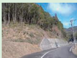
2-② バッファークーン整備後
