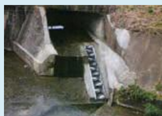
9-③ 用排水路・河川落差解消後
