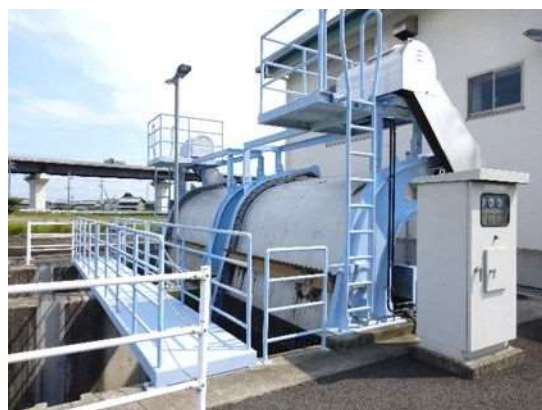
(除塵機完成後)
