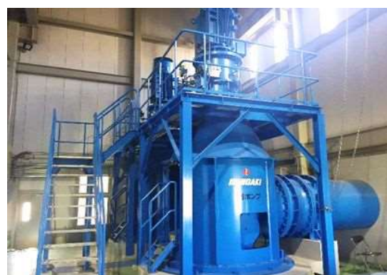
(ポンプ完成後)
