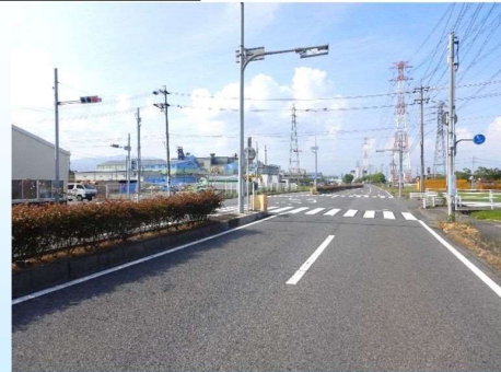
晴天時の状況 (大垣環状線 静里地区内) R5年8月
