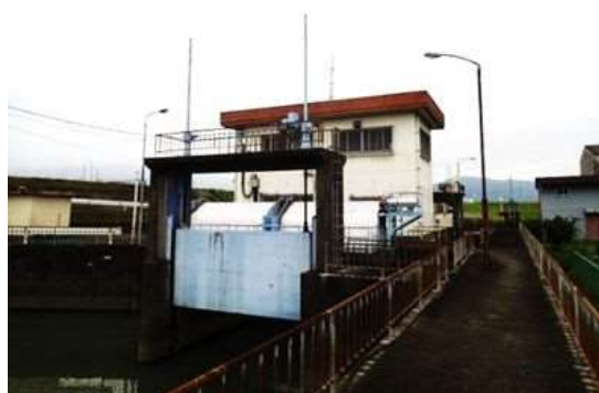
(除塵機着手前)
