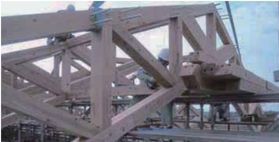
「拡張樹脂アンカー工法」ボルト↓樹脂は現場で施工
