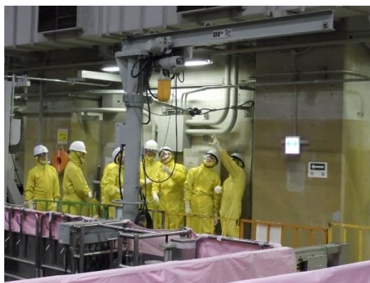
燃料プールを損傷させる可能性のある設備に施したワイヤーロープを点検している様子
