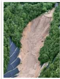
廃棄された土砂の崩落により 死者1名、重傷者1名 住宅被害1棟
