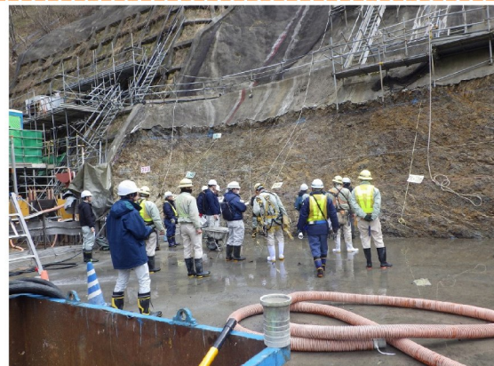
基礎地盤検査
