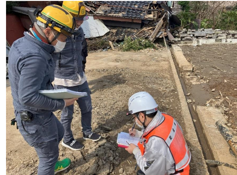
(解体工事完了検査の様子)
