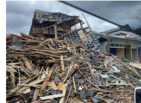
家屋の損壊状況
