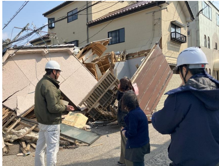
(解体工事着工前立会の様子)
