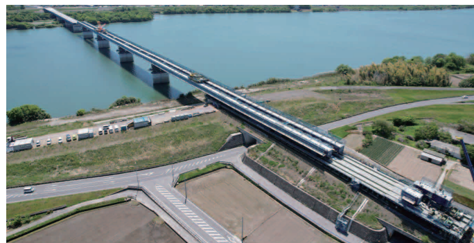
橋梁工事の様子（新濃尾大橋）
