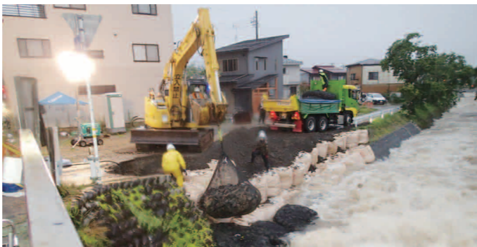
災害復旧作業
