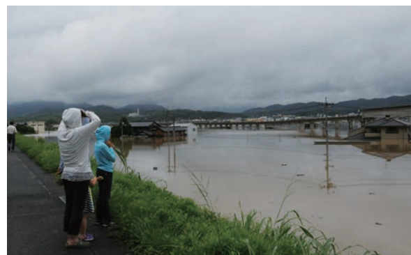
水没した街を見つめる住民 平成30年7月豪雨災害(岡山県倉敷市真備地区) 写真提供:岡山県
