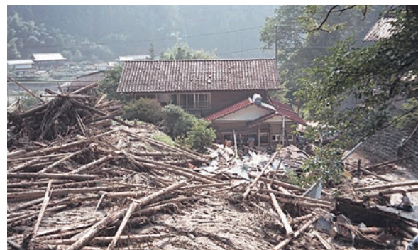
飯田洞での土石流 平成12年恵南豪雨災害(岐阜県恵那市)
