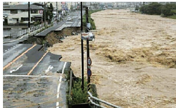
洪水による道路崩壊 平成30年7月豪雨災害(広島県広島市) 写真提供:国土交通省中国地方整備局
