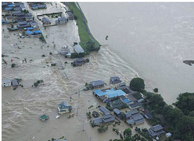
鬼怒川の破堤 平成27年9月関東・東北豪雨災害(茨城県常総市) 写真提供:国土交通省関東地方整備局
