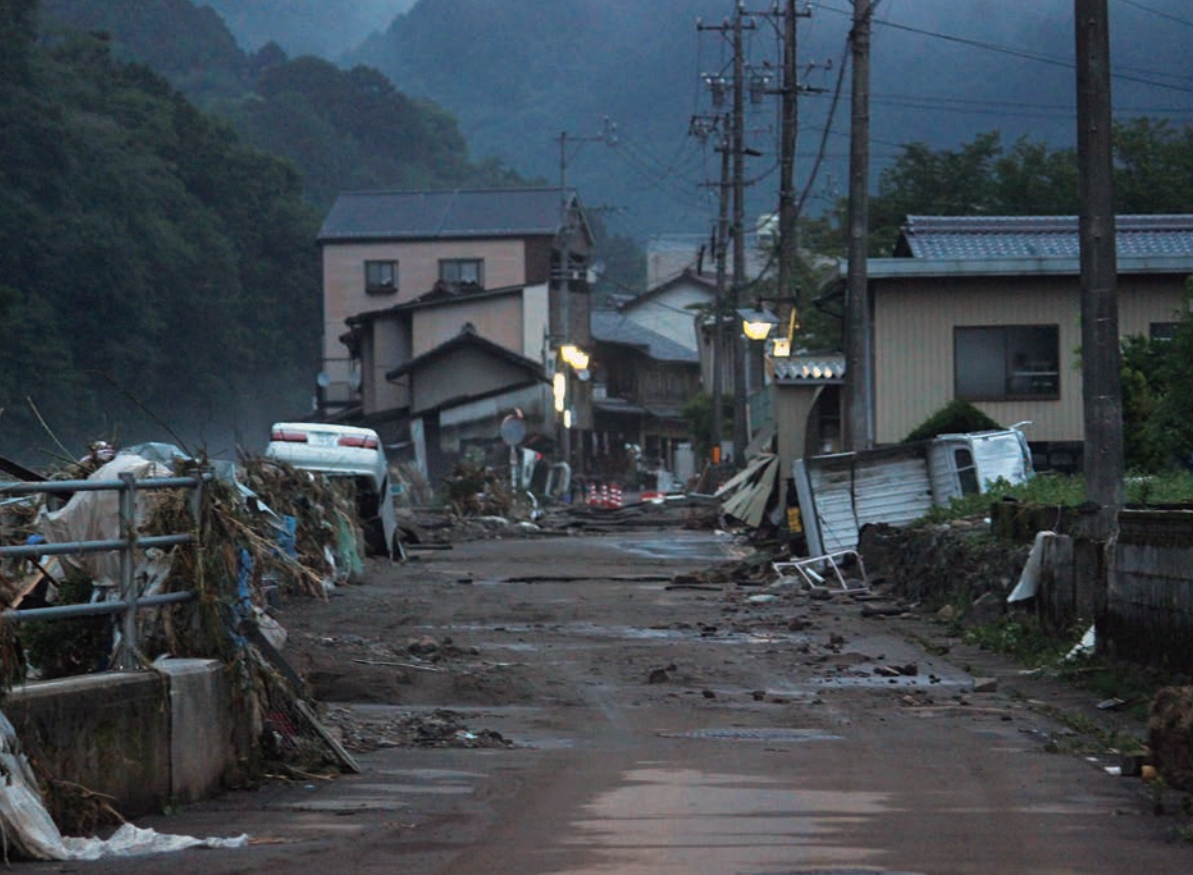
津保川氾濫による被害 平成30年7月豪雨災害(岐阜県関市)
