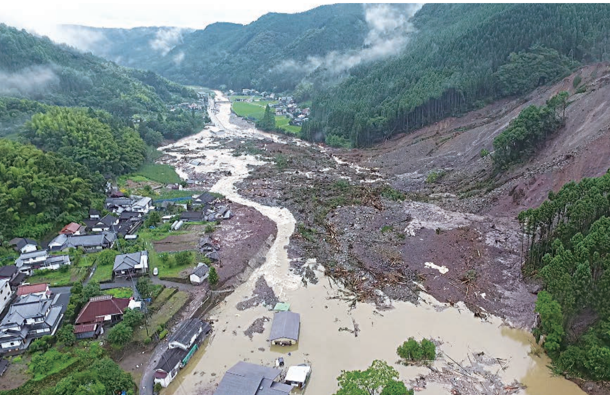
山田地区での土砂災害 平成29年7月九州北部豪雨(福岡県朝倉市山田地区) 写真提供: 国土交通省九州地方整備局
