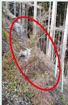
忌避剤施工被害あり 忌避剤
