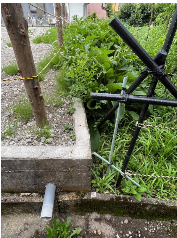
物件西側境界付近を撮影
