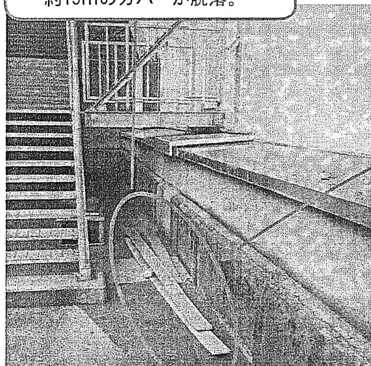
1, 2号機廃棄物処理建屋エキスパンション・ジョイントのカバー脱落
