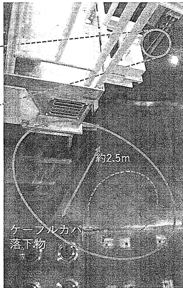
2号機 使用済燃料貯蔵プール落下物
