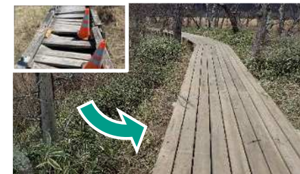
老朽化木道の改修等
