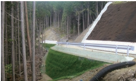
森林基幹道尾城山(5)開設工事
