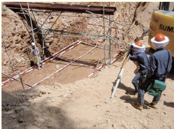
谷止工の床掘の高さ計測の様子
