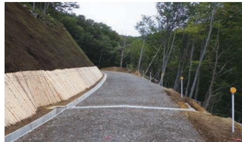
林道二間手～水沢上線(4工区)開設工事
