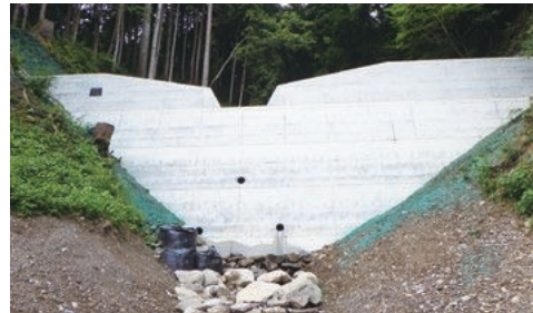
復旧治山事業小洞地区工事(補正)
