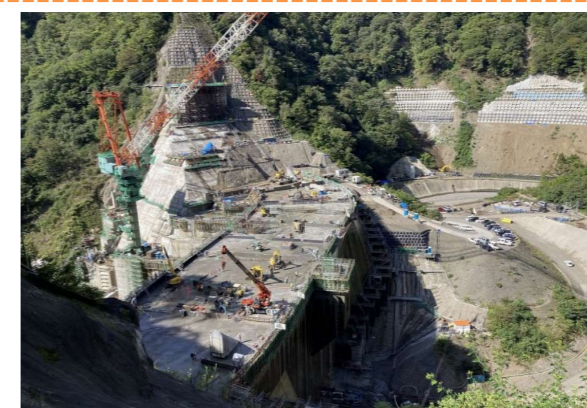
堤体上流側 EL536.75m
