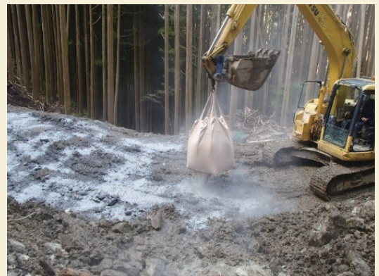
固化材散布の様子
