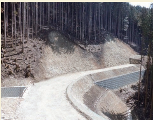
安定処理工 施工現場
