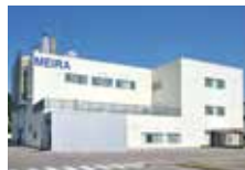
【Seki 3rd Plant】
