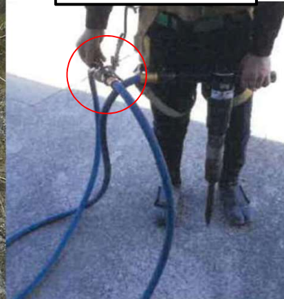
エアバルブ設置
