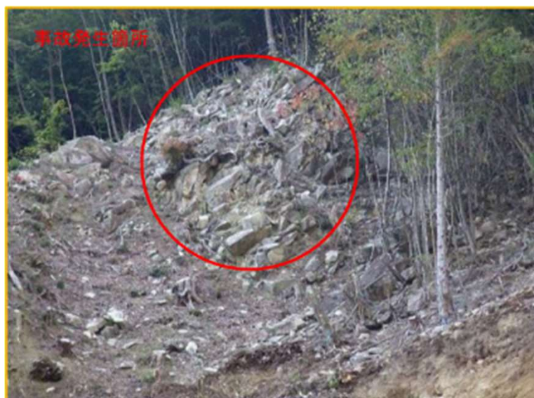
事故現場状況写真
