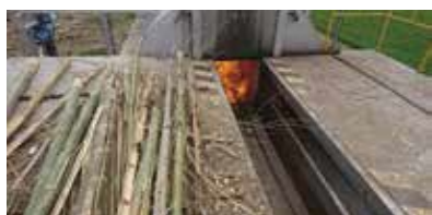
丸太ボイラーにて竹の燃焼状況を検証している様子
