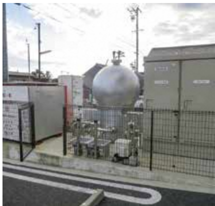
純水素型コージェネレーション燃料電池システム G-FORCE (八百津町)
