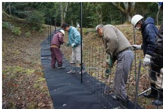
鳥獣防護柵設置状況
