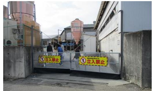
改善後の農場（門扉・看板の設置、場内の舗装）
