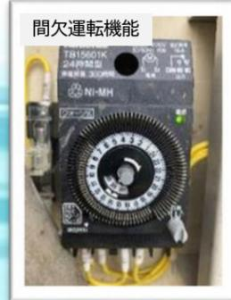
揚水のピークカットやピーク分散等により、水位低下を抑制する
