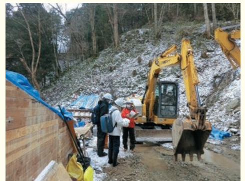
治山工事現場の見学
