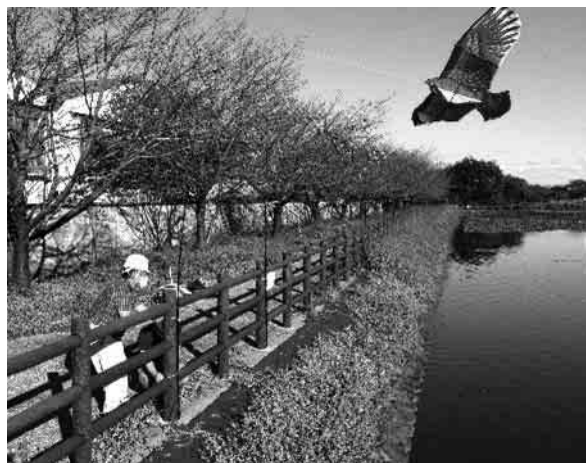
＜ため池の鳥よけ設置作業＞
