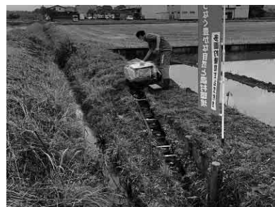
水田魚道の設置状況 〔水産研究所〕
