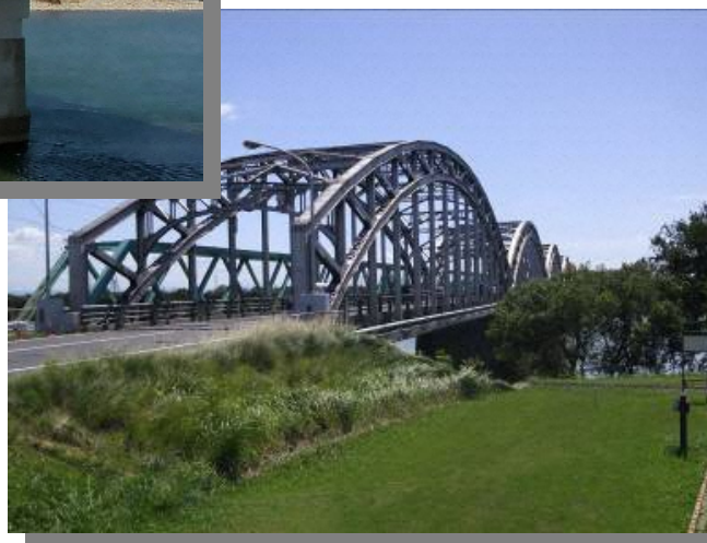
左：一般国道157号 忠節橋（岐阜市） 1948年架設（鋼ゲルバー式ブレースドタイドアーチ橋） 右：主要地方道 岐阜稲沢線 木曾川橋（羽島郡笠松町） 1937年架設（鋼ブレースドリブタイドアーチ橋）
