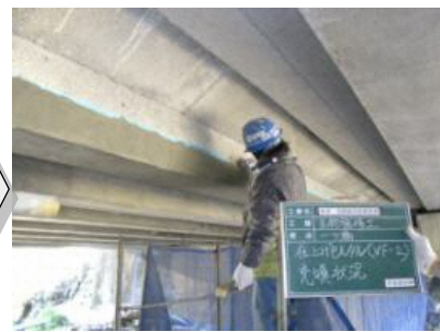
MEによる補修内容の指示に基づく補修
