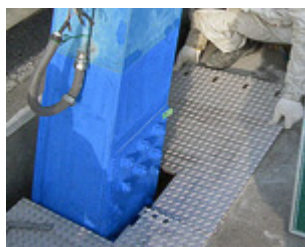
蓋の取り付け
