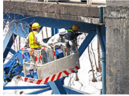
一般交通を規制しての詳細な点検
