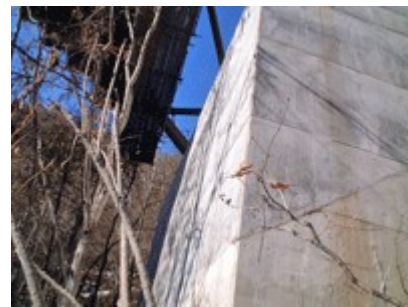
ひび割れ補修後
