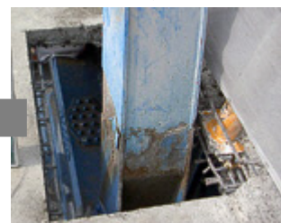
床版はつり完了
