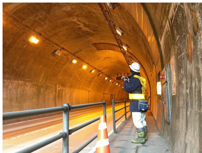
MEによるトンネル緊急点検
