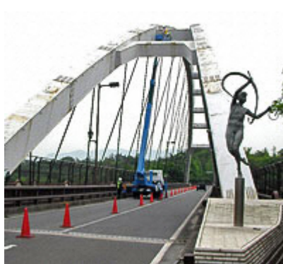
近接目視点検（下路ローゼ橋）
