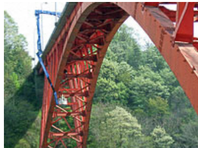
近接目視点検（上路アーチ橋）
