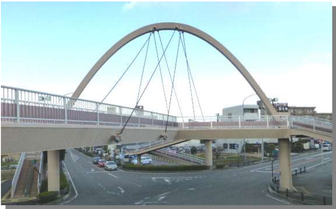
主要地方道 岐阜環状線 芋島歩道橋（岐阜市） 1999年架設（主塔ア一子型鋼斜張橋）
