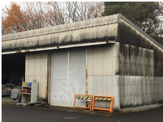
水防倉庫の外観
