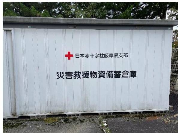
（日赤の設置する災害救援物資備蓄倉庫）
