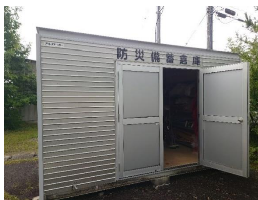
屋外の防災倉庫の様子
