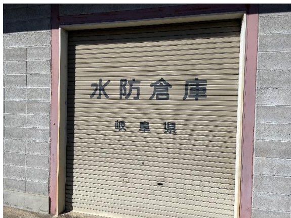
水防倉庫の外観
