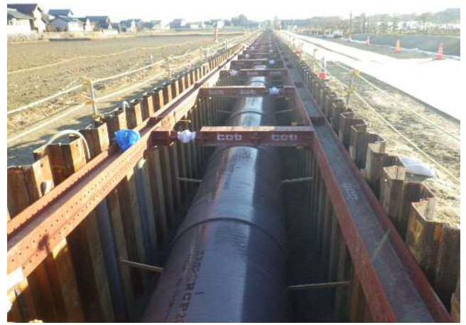
FRPM管φ2,000布設状況
