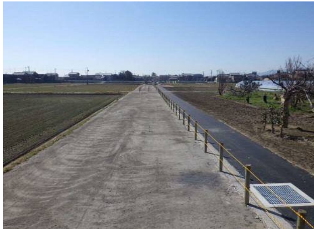
完成写真(埋戻し後)
