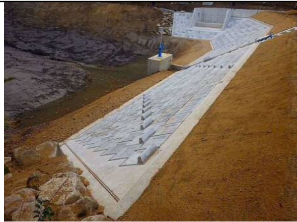
ため池上流張りブロック
