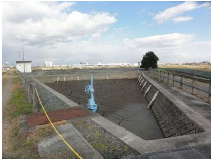
写真.2.3 河川浄化施設の例
