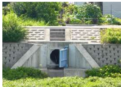
写真.2.2 樋門・樋管の例(断面積 5㎡未満)
