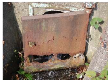
写真4.1 「d」の樋管の例
