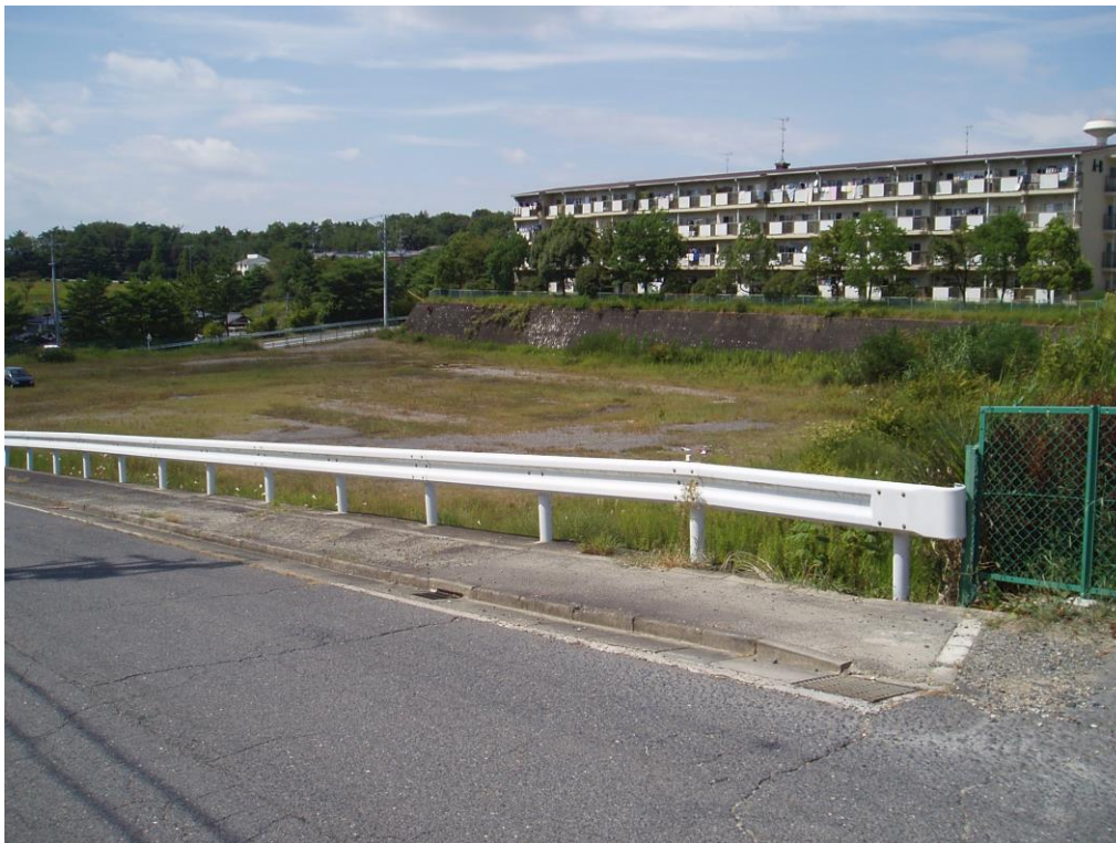
物件南東方向から北西方向を撮影（1 番 2 の全景）
