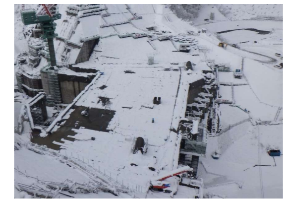
堤体状況(EL522.50m)
