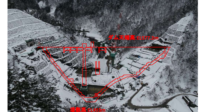
④ ダムサイト状況(上流上空より望む)
