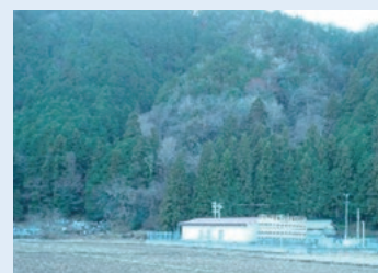
水道施設と水源林（関市富之保）
