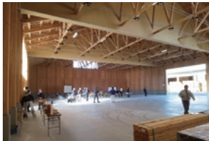
県産材を活用した非住宅建築物 (製品保管倉庫)
